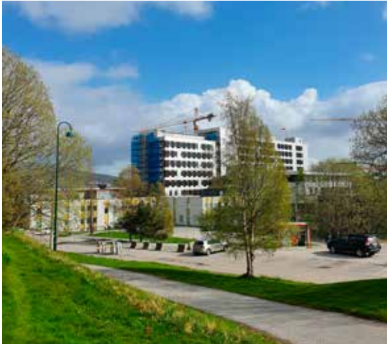
Sykehuset sett fra nordsiden. Fasaden er under utbedring
